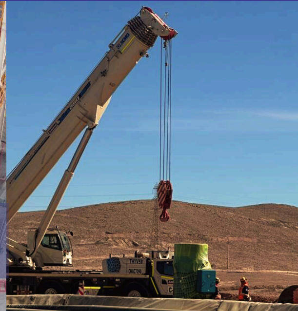
Servicio de Fabricación y Montaje Colector de Polvo N° 5 y 6., Minera Spence BHP.
