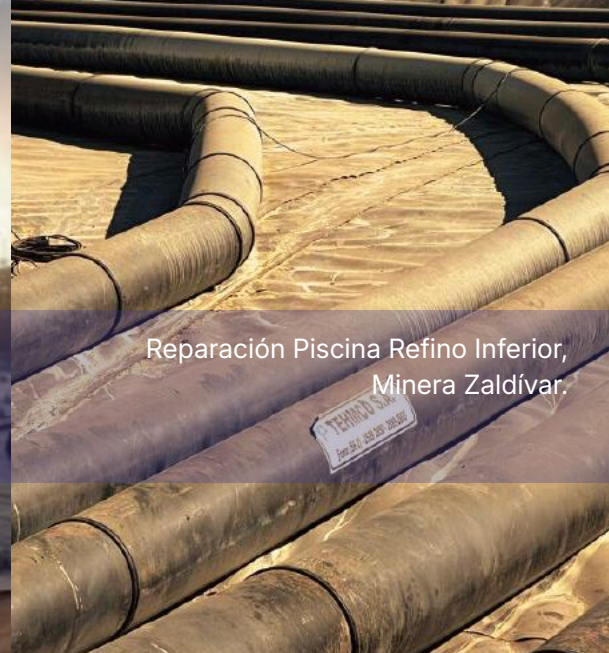
Normalización de Piscinas Efluentes, Codelco Chile División Ministro Hales.
